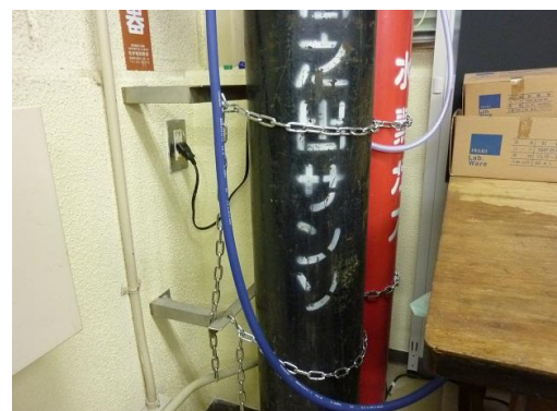
写真 - 8 ボンベ固定支持具
