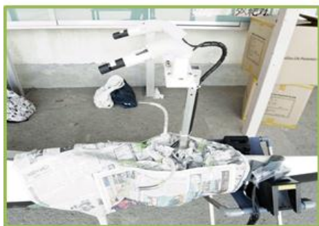
図2 フレキシブルチューブへFRPの塗布
